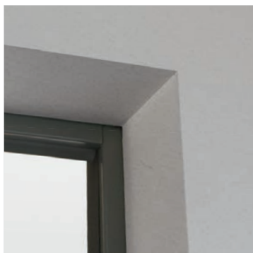
Renovatiesituatie met licht zichtbare kozijnstijlen
